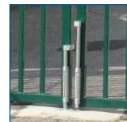
Second arrêt en ouverture (baïonnette + douille)
