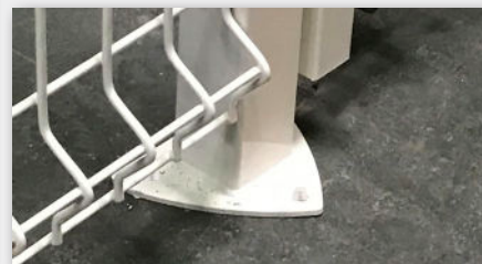
Piliers avec platines soudées.
