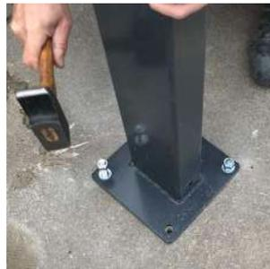
**4 /** Vérification et réglage de la bonne verticalité des poteaux avec des cales avant de serrer les vis.
