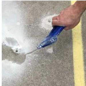
**2 /** Percer les 4 trous puis nettoyer à l'air comprimé.
