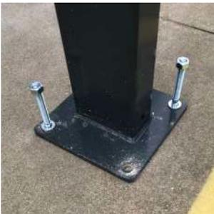
**3 /** Mettre en place les poteaux avec quatre tiges filetées.
