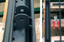
Attention au sens de la pièce, c'est le crochet (entouré en rouge) qui doit s'insérer au milieu de l'encoche. Une fois les pièces positionnées et avant de les fixer, vérifier que l'élément de barreaudage est bien aligné avec les pièces de fixation. Le crochet doit bien être au centre de l'encoche pour ne pas créer de décalage avec l'élément de barreaudage.
