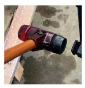
Une fois les poteaux préparés, fixer les bouchons de barreaux ainsi que ceux des lisses à l'aide d'un maillet. Il est plus facile de le faire avant que le barreaudage soit monté.
