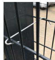
**6 /** Une fois votre gabion rempli, finaliser la pose avec la grille de finition haute en la fixant aux panneaux gabions grâce aux agrafes.
