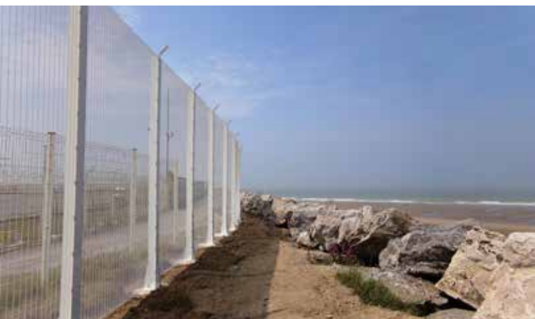
Coiffe : à prévoir pour renforcer la maille dense et rigidifier le panneau
